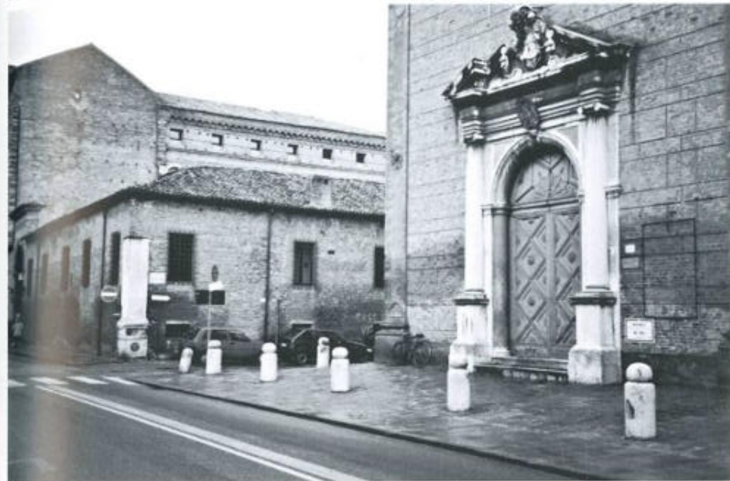
6/Il nodo viario -Ghiara-Porta d'Amore. L'incrocio è marcato dallo slargo creato dal sagrato della chiesa di Santa Apollonia e dal raffinato cantonale del palazzo di Ludovico il Moro.
