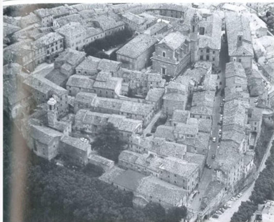
4/Corinaldo. Vista aerea da nord-ovest che evidenzia la «Piazza Grande», asse portante dell'assetto urbano rinascimentale.
