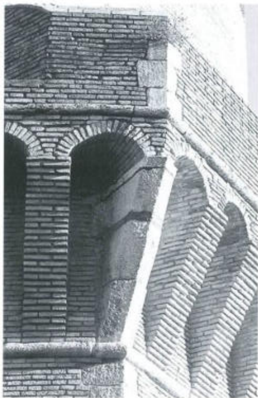
7-8/Ostia. Particolari delle soluzioni d'angolo dei beccatelli della rocca.
