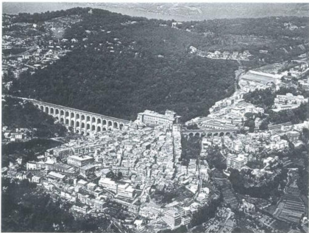
1/ Veduta panoramica di Ariccia. In primo piano il grandioso viadotto.
