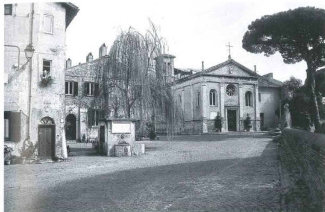
6/Uno scorcio del borgo di Ostia. A partire dalla destra si notano la basilica di S. Aurea, il fronte principale della casa dei particolari, la fonte e una parte della casa a schiera centrale.
