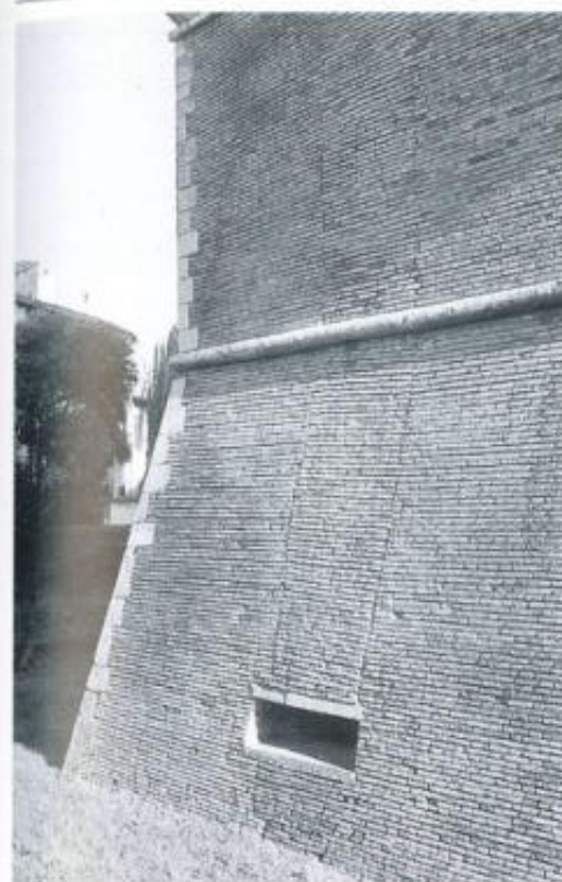
6/Ostia. Particolare del fronte settentrionale del puntone della rocca nel quale è evidente l'intervento di risarcimento della cortina muraria.
