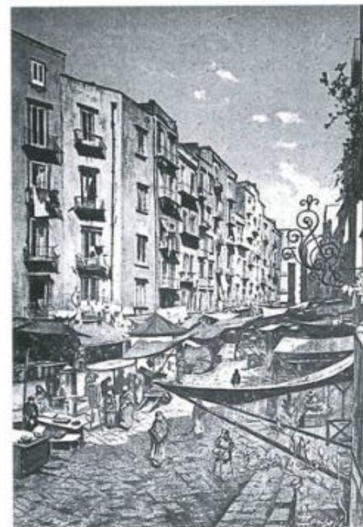
10/Napoli. La strada/piazza della Sellaria e del Pendino nella veduta di R. D'ambra (1889), quale spazio urbano unitario, prima della totale demolizione con i lavori per il Risanamento di Napoli.
