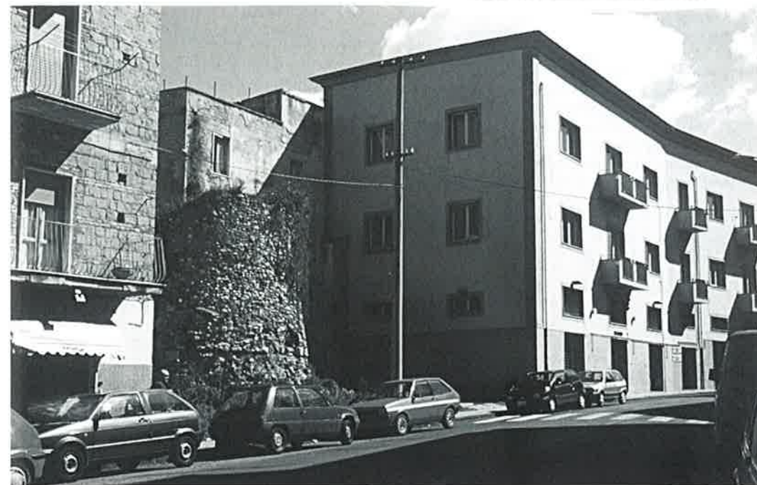
8/Benevento, Cancellazione della cinta muraria ad opera di edificazione recente.
