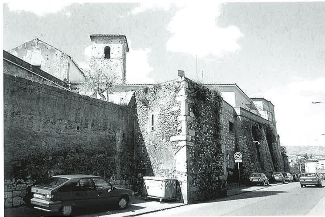
4/Benevento, L'ex convento S. Agostino.
