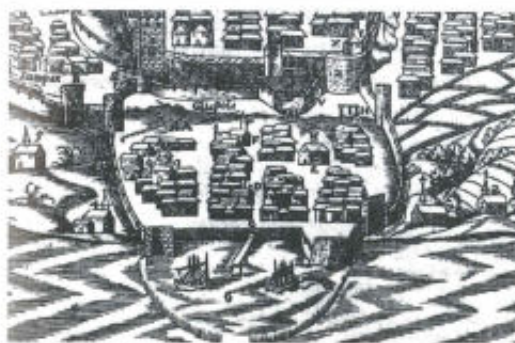
4/La Palizzata della Lapola, il porto pisano di Cagliari, in un particolare della veduta dell'Arquer del 1550 (da Principe 1981); era composta da 458 grandi pali infissi sul fondale e collegati da elementi in ferro. Il suo restauro, eseguito nel 1376-77 fornisce molti elementi per lo studio della sua struttura.
