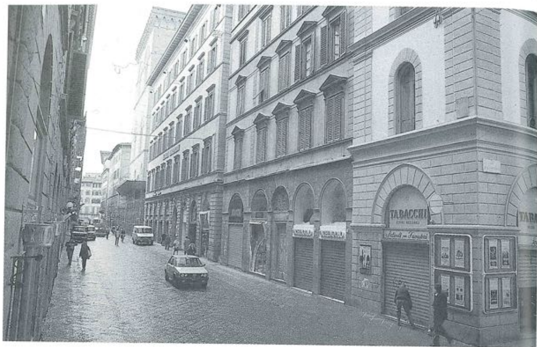
15/ Via Calzaiuoli - Stato attuale.
