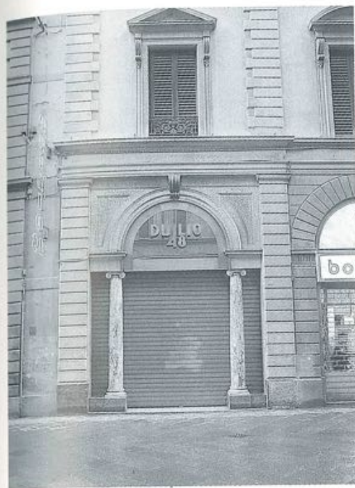
14/ Via Calzaiuoli - Portale del Bazar Bonaiuti.
