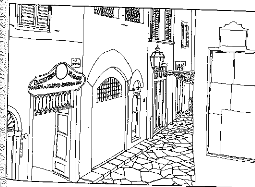
11/Lastrico alla rinfusa in Borgo S. Jacopo in un'immagine contemporanea (foto E. Pieri). Si noti come alla «calcina impastata con buona rena» sia stato sostituito il cemento.
