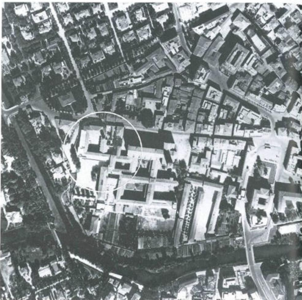
11/Treviso, le mura a sud-ovest ed i complessi di San Teonisto e San Nicolò. Selezione ingrandita da una ripresa IRTA databile anni '50 (Archivio Aerofototeca dell'ICCD. Autorizzazione alla divulgazione con concessione SMA n. 532 del 30-11-1995).
