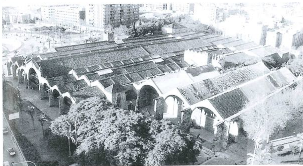
3/ Gli arsenali di Barcellona oggi in una veduta aerea (da «Dressana». Revista del Museu Maritim, n. 3, 1995, p. 1).
