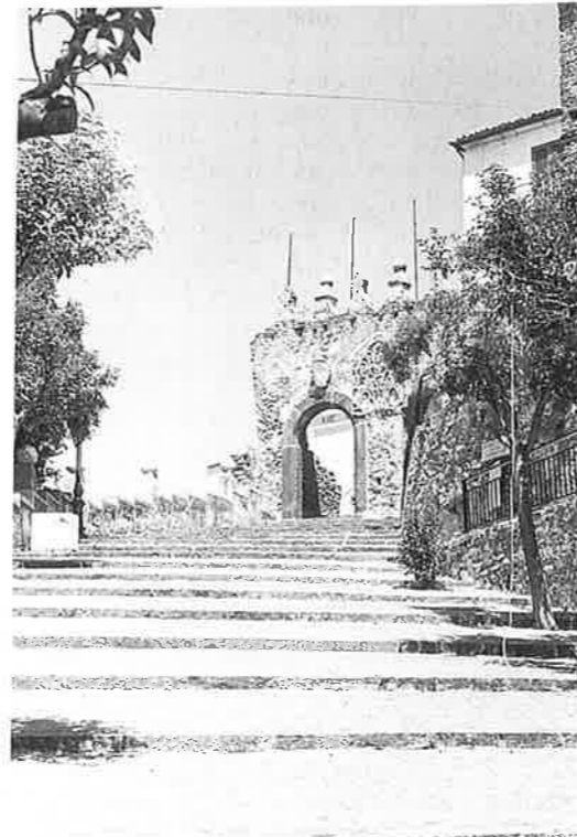
7/Agropoli. Particolare della porta principale lungo gli scaloni di via F. Patella (foto dell'a.).
