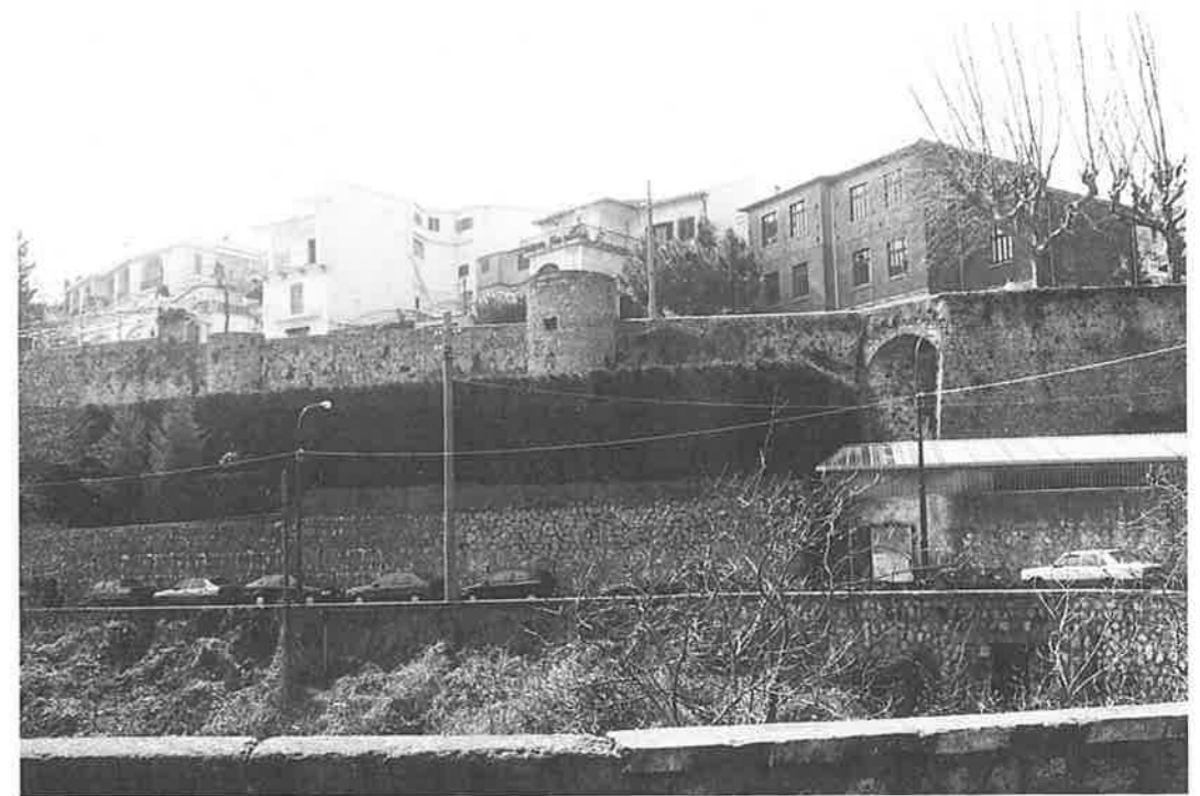
4/Il fronte orientale della cinta muraria e delle torrette durazzesche (2* e 3*) (a cura dell'a.).
