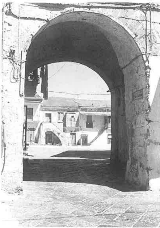
11/Porta sud e vista del Largo San Castrese (foto dell'a.).
