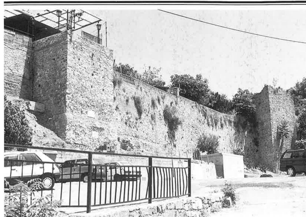
10/Agropoli. Particolare della cinta muraria, lato sud-est (foto dell'a.).
