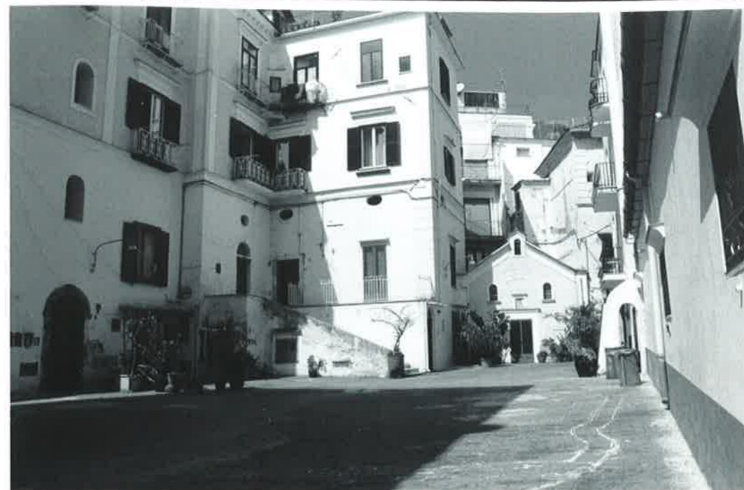
14/ Amalfi. Lo spazio pubblico- detto il Largo lastricato - costruito sopra la copertura dell'Arsenale di Amalfi (foto dell'a.).
