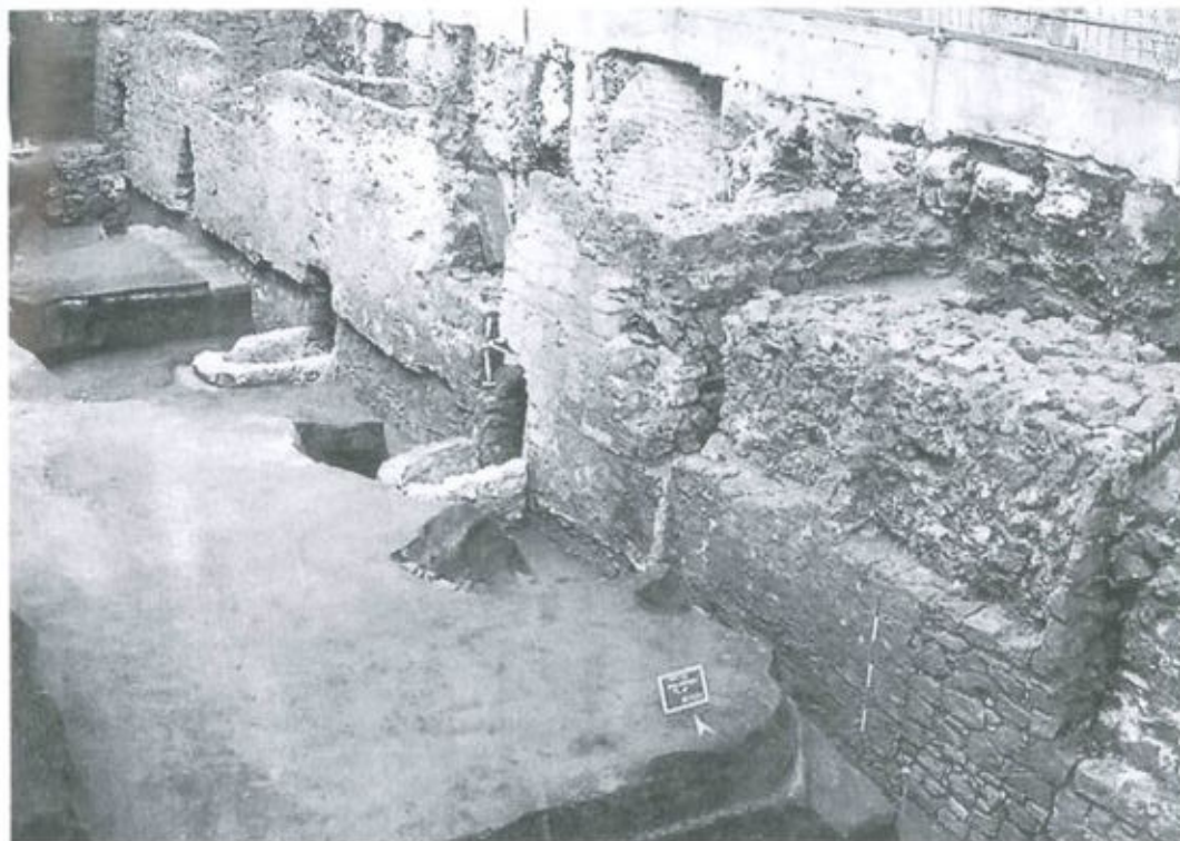
3/ Napoli. I resti delle mura aragonesi occidentali (1489-1501) lungo via Toledo, venute alla luce negli scavi della Metropolitana, Linea 1, Stazione Toledo, nel febbraio 2007 (da «Il Mattino»).
