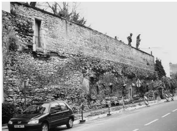
3/ Digione. Resti del muro di sostegno interno di 13 baraccia rispetto alla muratura esterna nell'area meridionale della città. È visibile l'altezza del percorso sopraelevato interno alle mura grazie alla differenza di colore e all'apertura presente.
