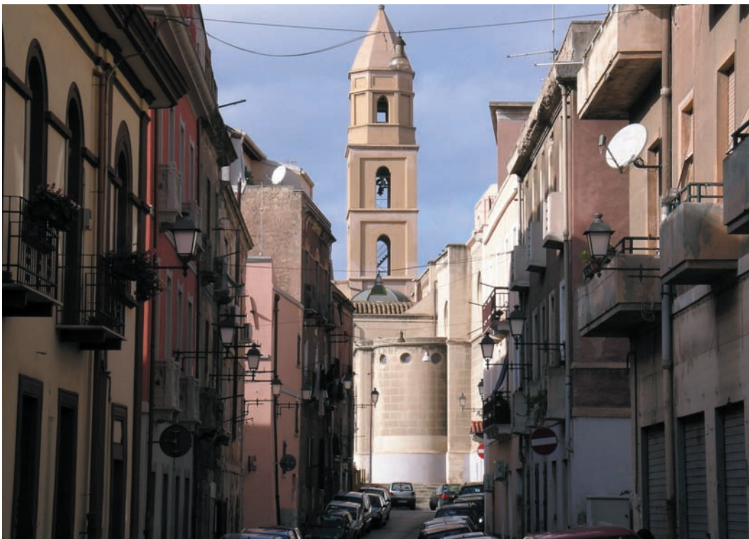
Le strade nuove della Marina: via Cavour, utilizza il campanile di Sant'Eulalia come architettura di fondale e regola la parte orientale del quartiere aragonese, pianificato unitariamente al nucleo centrale e probabilmente assegnato nel tempo.
