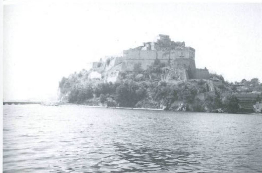
4/Baia. Il forte e la torre visti dal mare, prima dei recenti restauri (foto dell'a. 1991).
