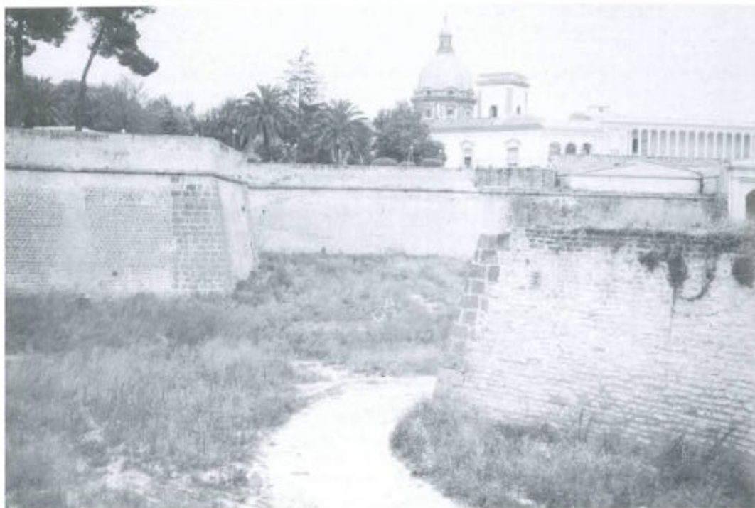
8/Capua. La cinta bastionata ed il fossato dopo i recenti restauri dei 1992-93 (foto dell'a.).
