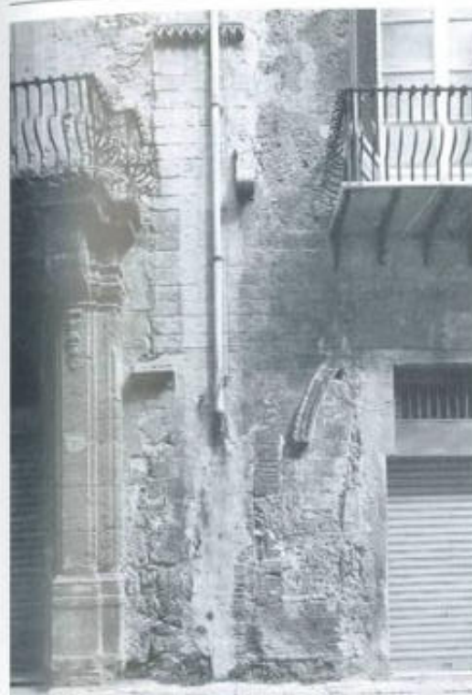
3/Palazzo Spedalotto, tracce di strutture trecentesche (foto F. Filangeri).
