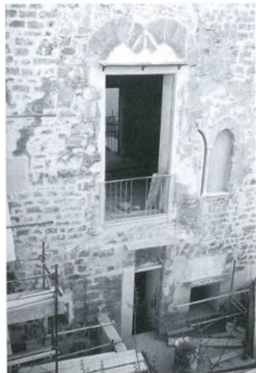
5/Palazzo Plaia di Vatticani. Parte del prospetto su via Venezia: si riconosce il sistema delle due bifore quattrocentesche disposte in asse e la più antica bifora alla pisanisca .
