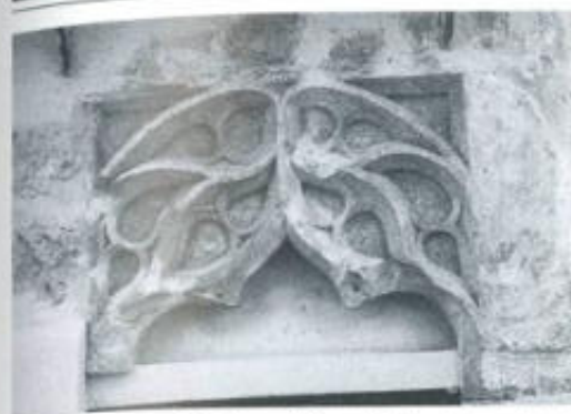
4/Palazzo Plaia di Vatticani. Uno dei due elementi che costituivano l'architrave traforato della bifora quatra dell'ambiente al piano terra sul fronte di via Venezia.
