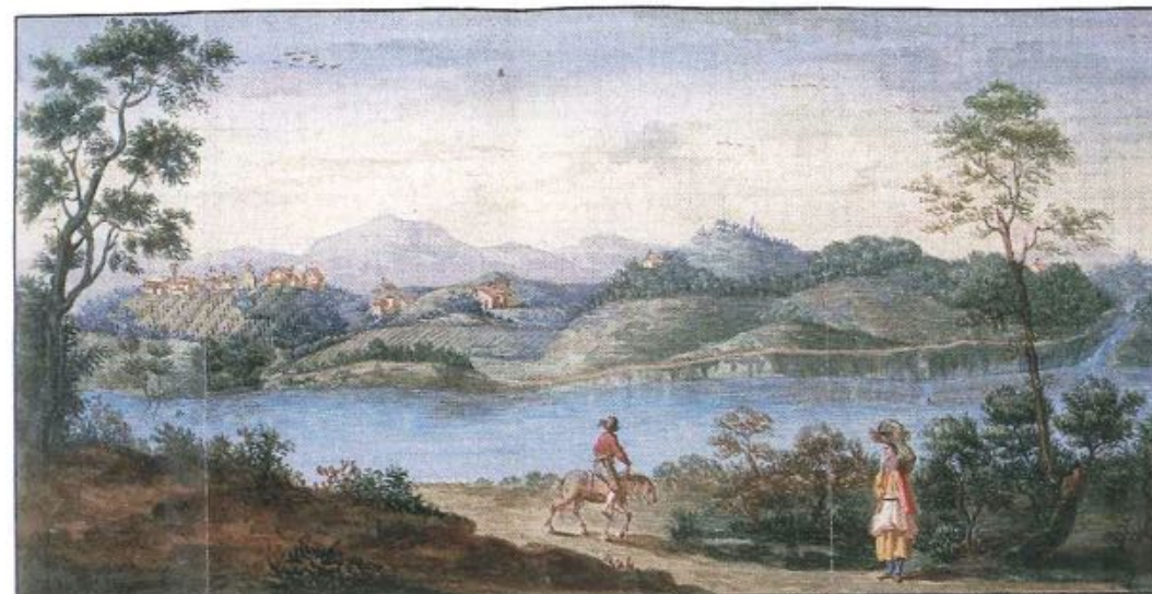
VEDUTA DE' POGGI, CHE CONGIUNGONO ROMENA COL BORGO-ALLA-COLLINA NEL CASENTINO. 1. Lago di Collina 2. La Spallata, alla Strada Fiorentina 3. Chiesa parrocchiale di S. Paolo 4. Casa del Podestano 5. Capo del Casale 6. Torre di Casaglia 7. Rio di Casaglia, che divide il Poggio di Romena dalla Collina di S. Paolo 8. Fiume Arno 9. Strada che conduce dal Borgo alla Collina
