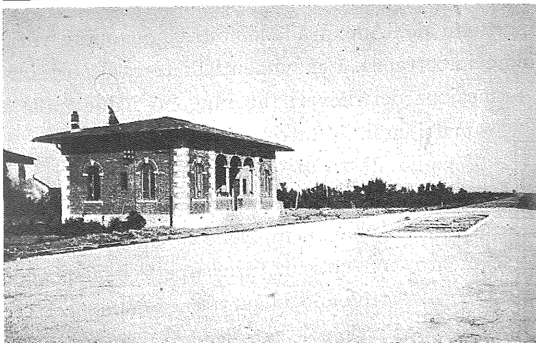
2/Il piazzale d'ingresso a Firenze con la stazione, al contempo casello e casa cantoniera.
