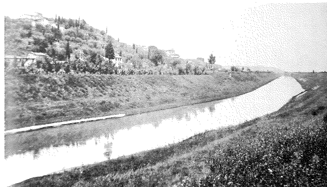
18/ Veduta del Canale dell'Usciana a S. Maria a Monte.
