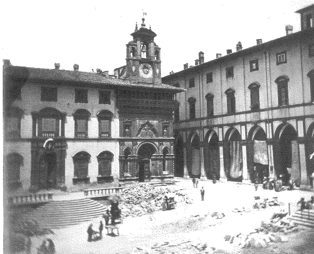
6/ Lavori di pavimentazione in Piazza Grande alla metà dell'Ottocento in un'immagine stereografica di A. Hautmann. Sulla piazza è collocato il monumento a Ferdinando III eretto nel 1822 e spostato nel 1932.
