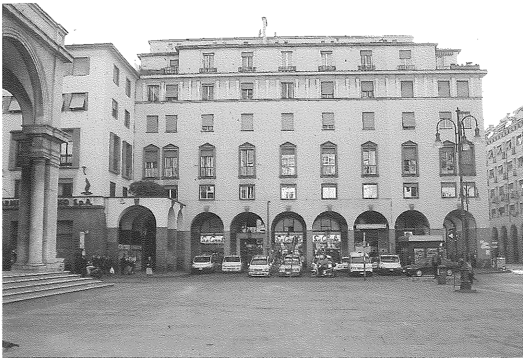
19/ I nuovi portici del lato occidentale di piazza Duomo.
