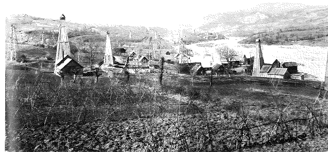
2/ Veduta dei pozzi sulla Costa del Sud. A destra, il pozzo di cui alla veduta di figura 3.
