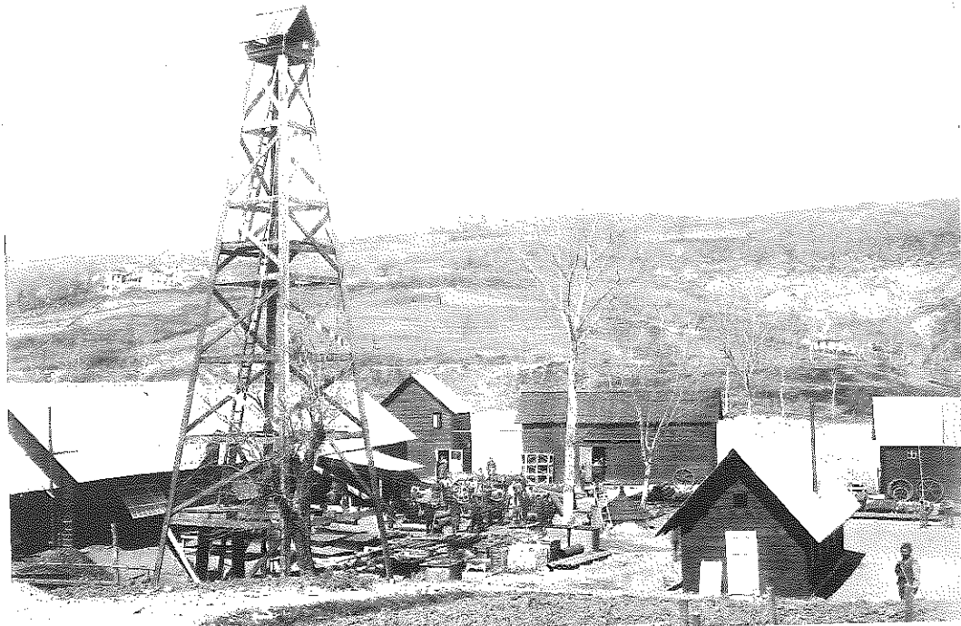
3/ Veduta del pozzo sulla riva del Chero.
