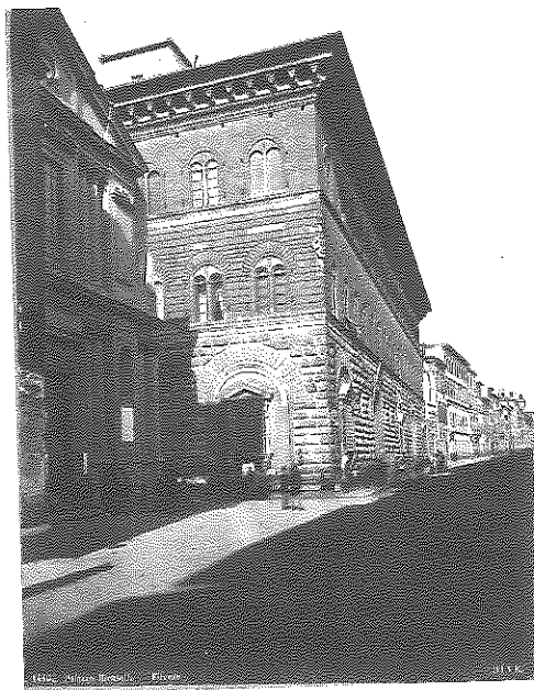
4/ R. Rive, «N.° 1446. Palazzo Ricasoli. Firenze», «RIVE»; stampa su carta albuminata, 25,2x19; 1870 circa. Si tratta del palazzo Medici-Riccardi in via Larga. L'effetto di profonda prospettiva della via è accentuato dall'ampia ombra portata sulla carreggiata dal prospetto orientale della via. Al margine sinistro dell'immagine, sul prospetto del convento degli Scolopi sono incollati vari manifesti, fra cui uno di un'associazione di belle arti e uno di un dentista. Sulla piazzetta davanti alla chiesa di San Giovannino degli Scolopi è parcheggiato un carro. Sulla panca di via del palazzo Medici-Riccardi sono disposte merci di diversi venditori ambulanti e, in corrispondenza dello spigolo del palazzo, un lampione a stelo in ghisa con lanterna.
