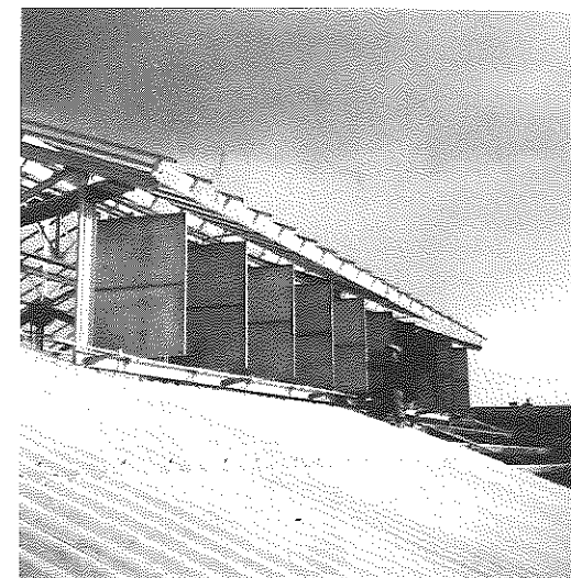
5/ N. Baroni, il lucernario metallico del Rex in costruzione, [ottobre 1937?] (Archivio Baroni, Firenze).
