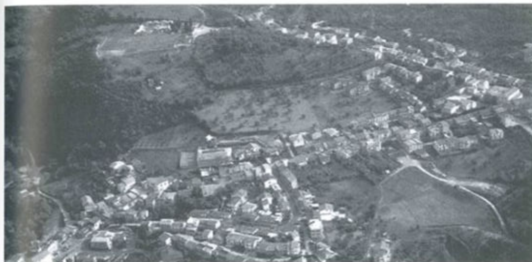
5/ Castel Baronia (Acquara). Veduta aerea attuale (da www.prolococastelbaronia.it )
