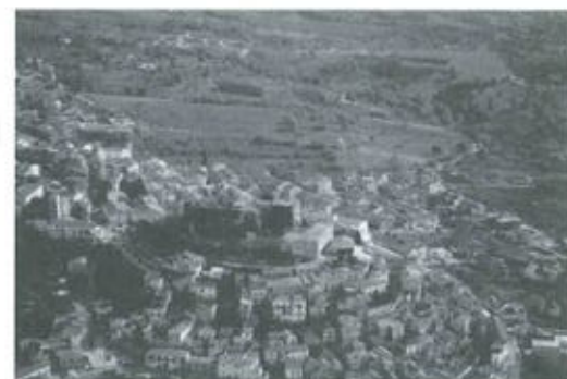
15/ Gesualdo. Centro urbano, vista aerea (da www.comune.gesualdo.av.it ).
