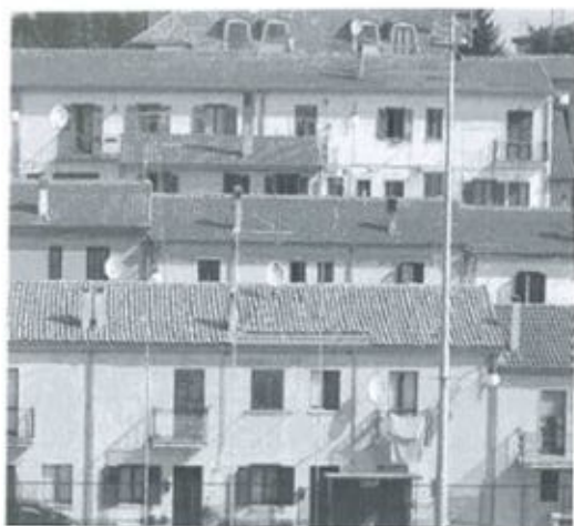
10/ Sant'Angelo dei Lombardi. Borgo di S. Rocco dopo il restauro in seguito al sisma del 1980. Foto a cura della Soprintendenza per i BAPPSAE di Salerno e Avellino, Istituto Comprensivo "V. Crisculi", Sant'Angelo dei Lombardi, I PERCORSI DI "GENIUS LOCI", 2005.
