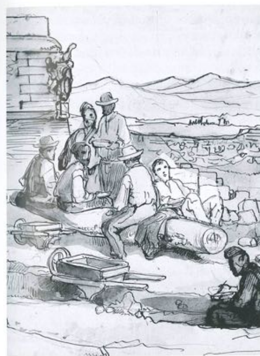
7/ G. Moricci, Lavori alla Fortezza da Basso , 1867-68. (Firenze, Archivio fotografico Soprintendenza al Polo Museale, 306202) Nel suo acquerello il pittore fissa i profondi sconvolgimenti che interessano l’area per l’apertura dei nuovi viali.
