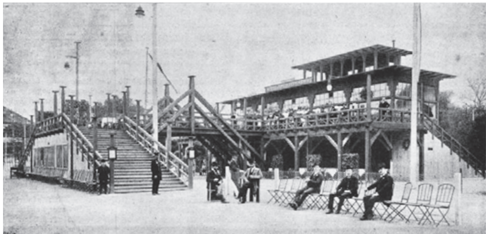
Fig. 5. Max Fabiani, Il Terrassencafé per l'esposizione del 1904 (da «Wiener Bauindustrie Zeitung», 1904, p. 327).
