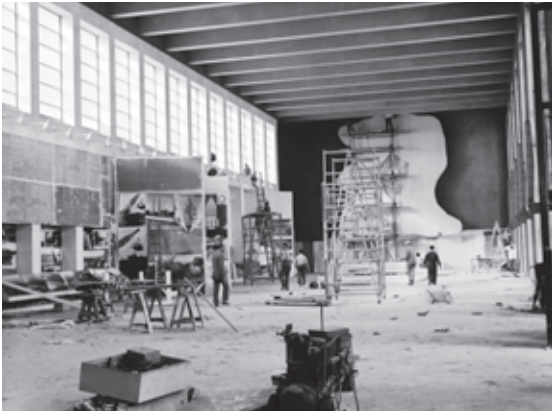
Fig. 4. Si allestisce il salone delle Fontane nel Palazzo degli uffici dopo il restauro, 1952 (A.C.S.).
