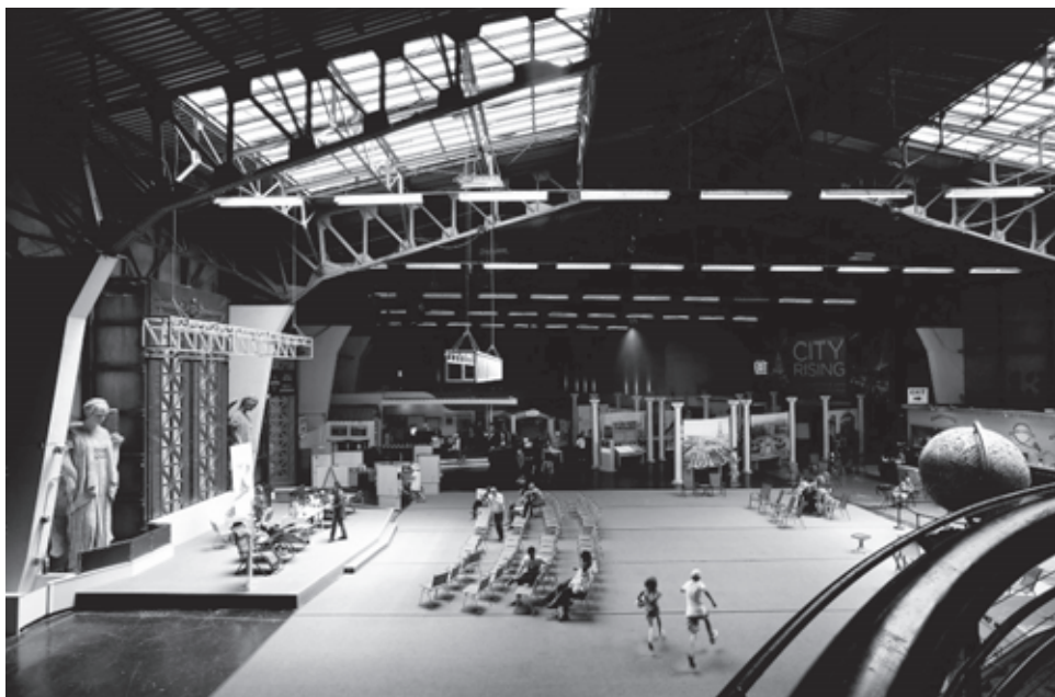
Fig. 15. Palazzo delle Belle Arti: veduta della struttura portante e dell'interno di una delle sale destinate al Museo Exploratorium. (da San Francisco Chronicle).
