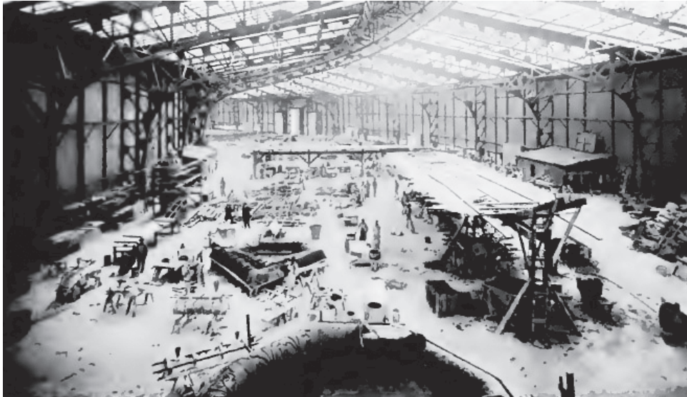
Fig. 14. Palazzo delle Belle Arti: veduta della struttura portante e dell'interno della sala. (da Todd, The Story , cit., p. 18).
