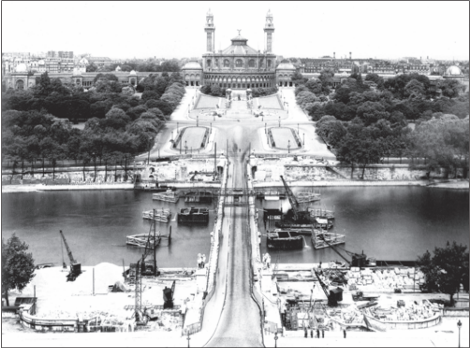
Fig. 5. I lavori per l'allargamento del Pont de Iéna, 1935 (sullo sfondo il vecchio Palais de Trocadéro).
