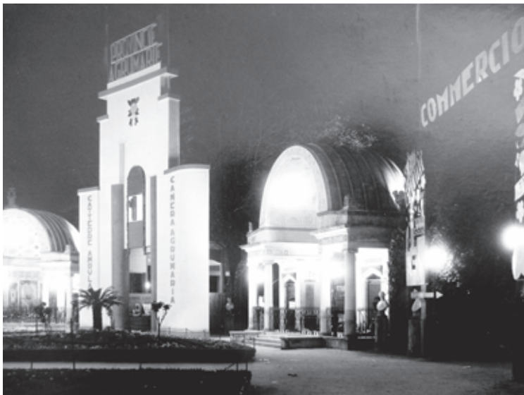
Fig. 9. Illuminazione notturna della piazza centrale con il padiglione delle Provincie Agrumarie tra i due "cisternoni" di Giuseppe Damiani Almeyda e l'invito alla galleria del Commercio (Archivio Fotografico, Fondo Caronia Roberti, Collezioni Scientifiche del Dipartimento di Architettura, Università degli Studi di Palermo).
