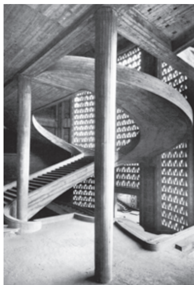
Fig. 15. Musée des Travaux Publics (Auguste Perret): la scala in cemento armato.
