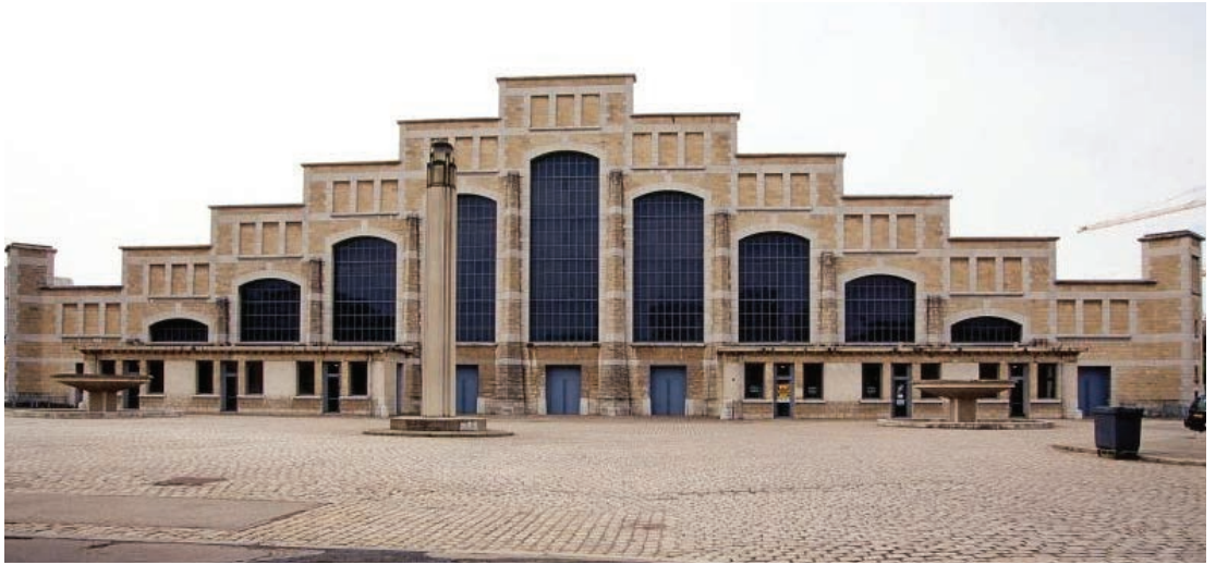
*Fig. 6. Halle Tony Garnier. Dettaglio della facciata in muratura.
