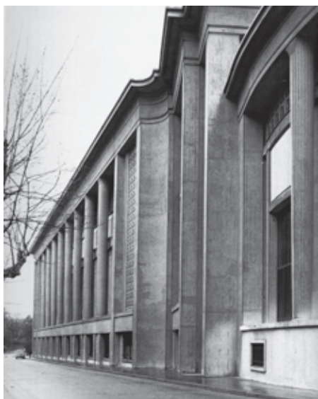
Fig. 14. Musée des Travaux Publics (Auguste Perret): l'ordine gigante lungo la facciata laterale.
