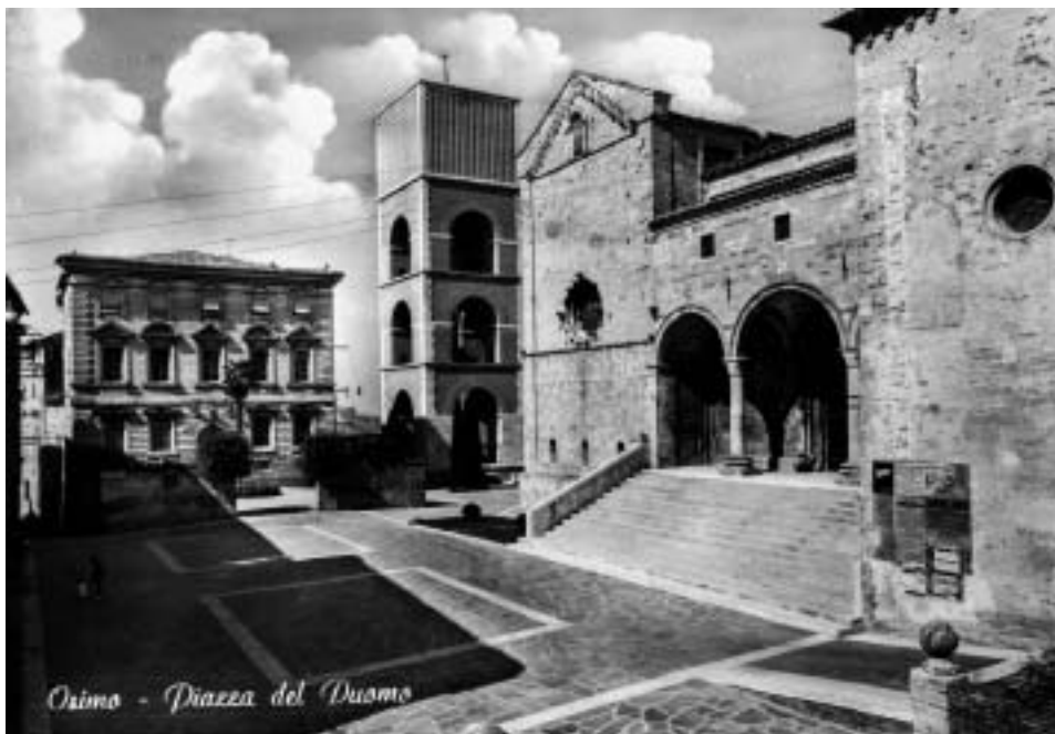
Fig. 6. La sistemazione della piazza del Duomo a lavori della torre completati (BCC)
