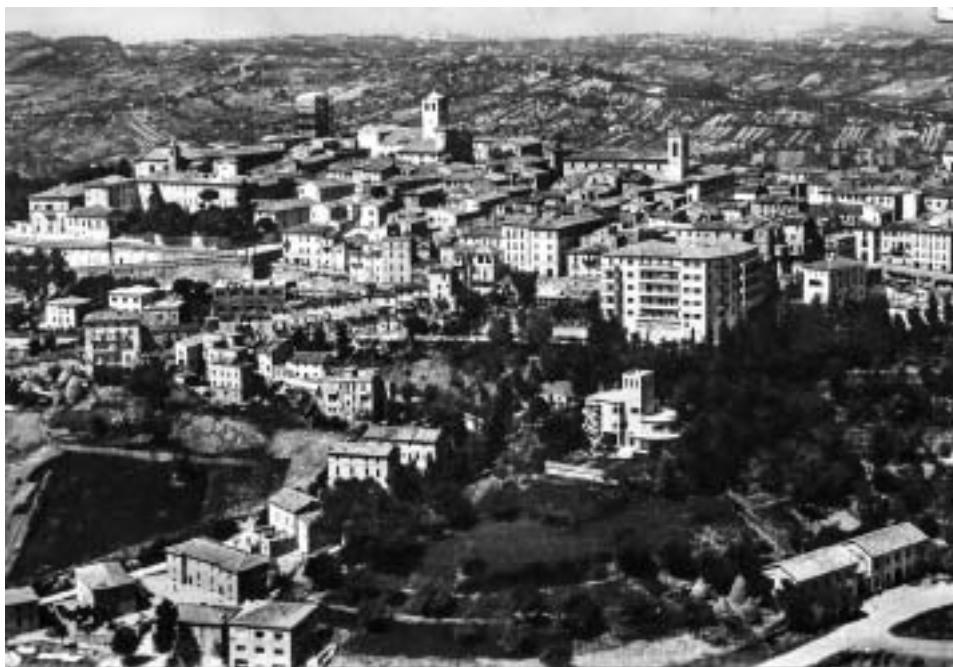
Fig. 5. Veduta del Gòmero nei primi anni Cinquanta, durante la costruzione della nuova torre dell'acquedotto (BCC)
