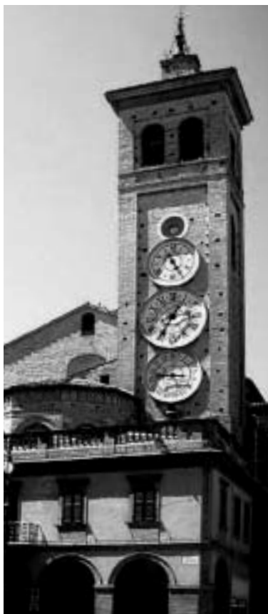
Fig. 25. La Torre degli Orologi di Tolentino (MC) in Piazza della Libertà ha una macchina collegata a quattro quadranti per indicare le fasi lunari, le ore italiche, l'ora astronomica e i giorni della settimana e del mese. È opera di Antonio Podrini di Sant'Angelo in Vado che lo costruì nel 1822.
