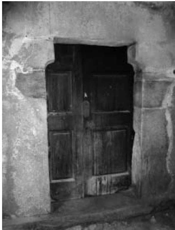
Fig. 9c e 9d. Marmora, ruata Reinero. Casa 'di Mosè', già Reyneri: resti del portale su strada e portoncino dell'appartamento inferiore.
