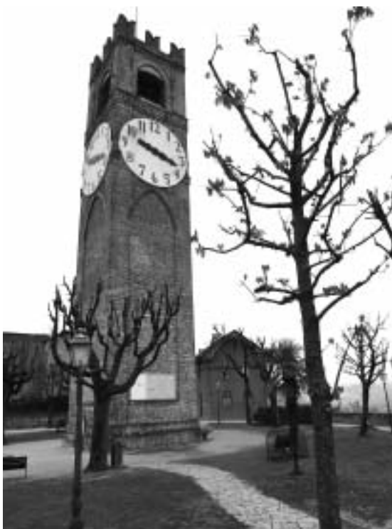
Fig. 3. Mondovì. La Torre dei Bressani nel giardino del Belvedere dopo il restauro alla metà dell'Ottocento (G.B. Gorresio, Ufficio d'Arte del Comune).
